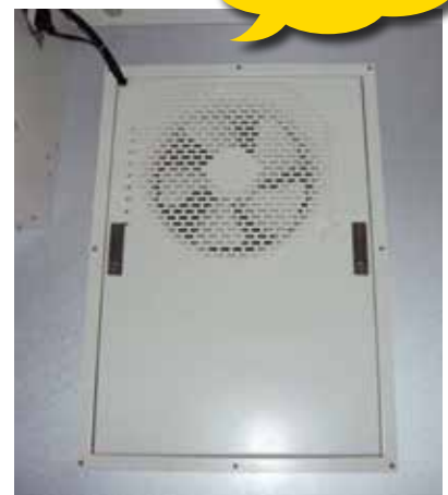
陽圧換気扇床収まり設置例
